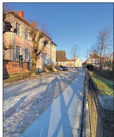
Großprojekt: Gegenüber dem Haus Gierke/Heising (l.) am Steinweg entstand um 1805 die neue katholische Kirche Rhedas. Das hatte auch Auswirkungen auf den nahen Doktorplatz.
